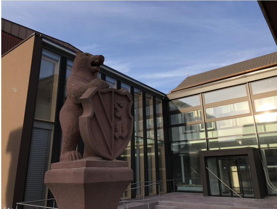
Abbildung 11: Der neue, barrierefreie Zugang des Rathauses.
