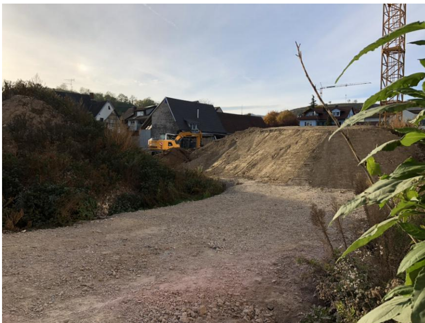
Abbildung 14: Baustelle beim Rathaus: Hier soll ein Fußgängerweg entstehen.
